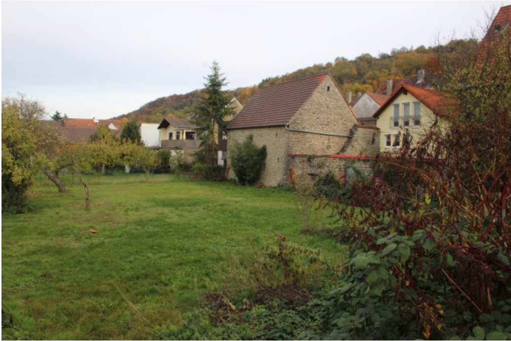
Abbildung 2: Ostseite von Süden mit angrenzenden Nebengebäuden
